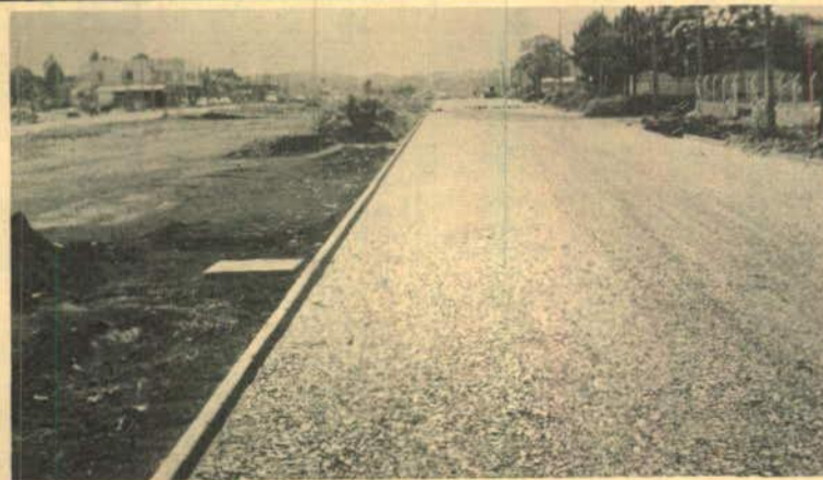
Pavimentação da segunda pista da Av. Foz
