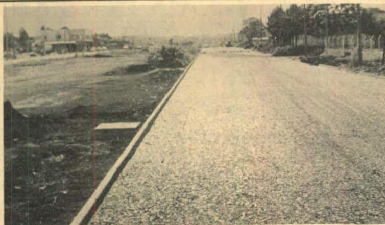
Pavimentação da segunda pista da Av. Foz
