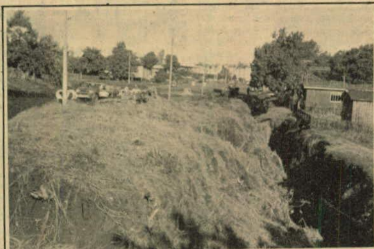
Em Corbélia, a recuperação de trechos das Ruas Paraná e Minas Gerais
