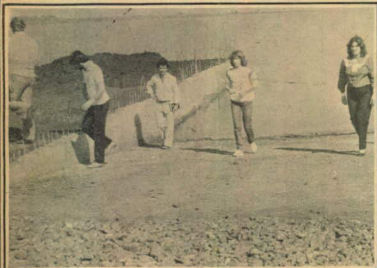
O ancoradouro está quase concluído.
