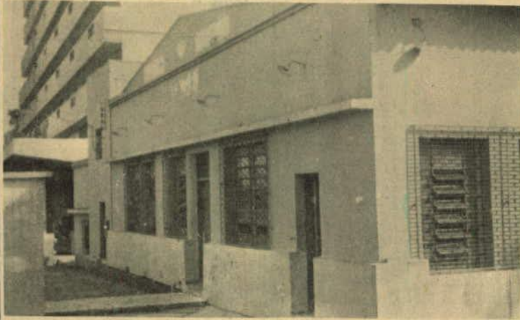
Neste prédio, onde estava instalada a PM, o Servim faz trabalho de recuperação do menor.
