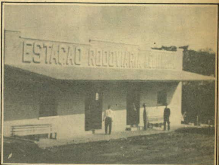
A estação rodoviária: 1963.
