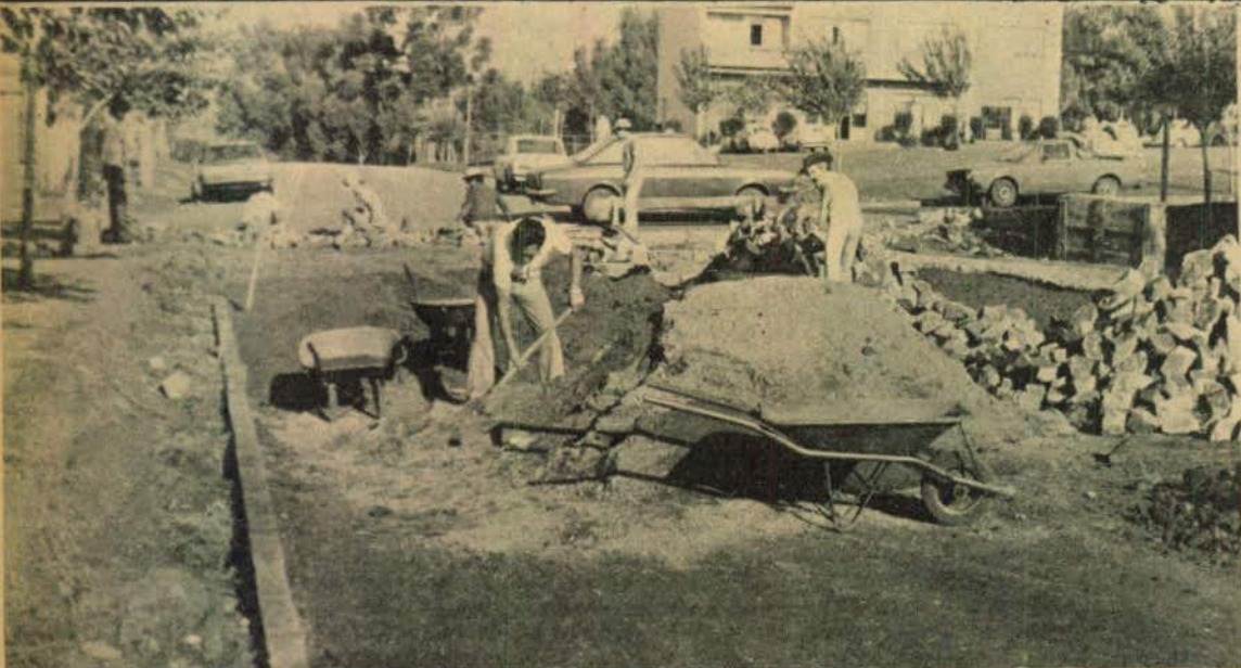
Ruas de Catanduvas estão sendo pavimentadas com pedras irregulares
