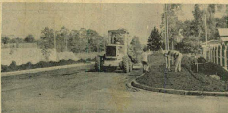
Na cidade de Cafelândia diversas ruas estão sendo pavimentadas
