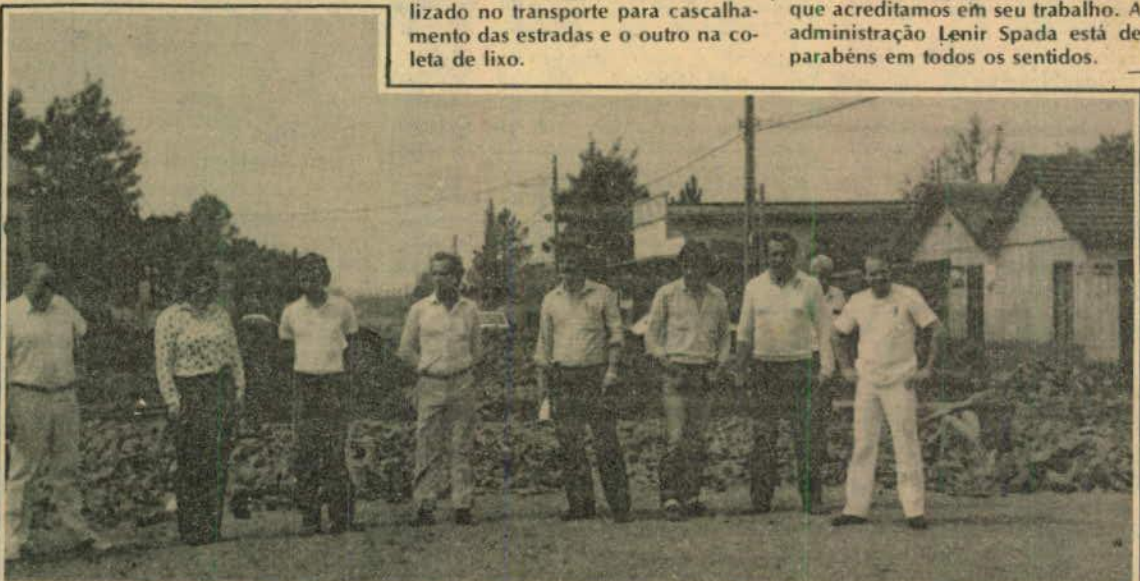
Autoridades observam as obras de pavimentação com pedras irregulares.
