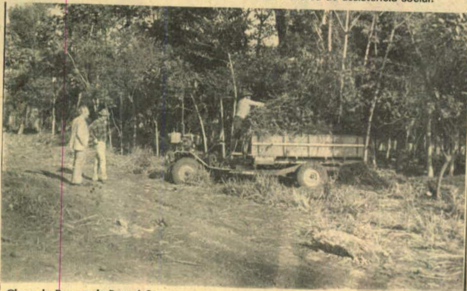
Obras do Parque de Exposições
