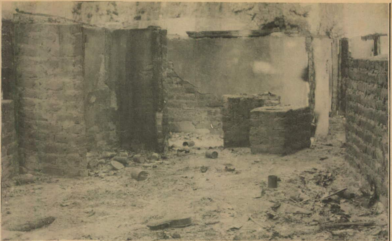
Casa incendiada por capangas de latifundiários
