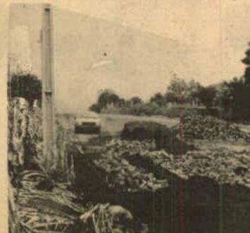
Obras de melhorias em ritmo acelerado
