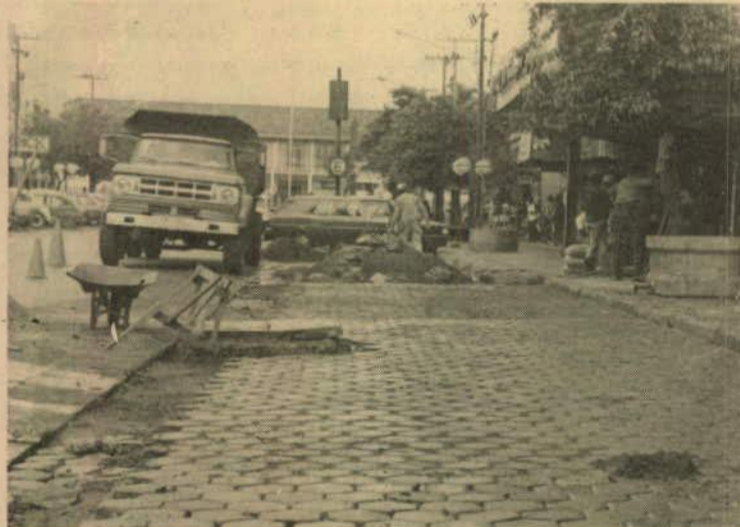
A Administração Municipal está ampliando os estacionamentos na Avenida Brasil
