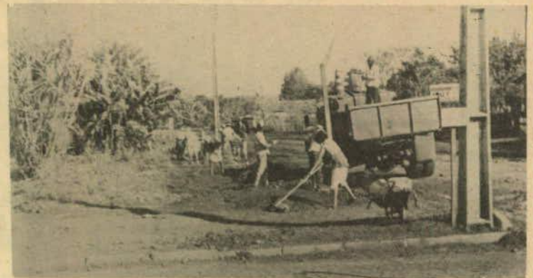
Operários trabalhando na limpeza de ruas, valas e bueiros
