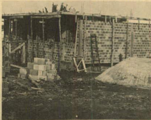
Mini-Posto de Saúde - em Construção no Bairro Parque dos Estados -
