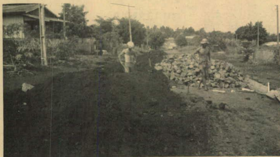
Preparação para pavimentação poliédrica
