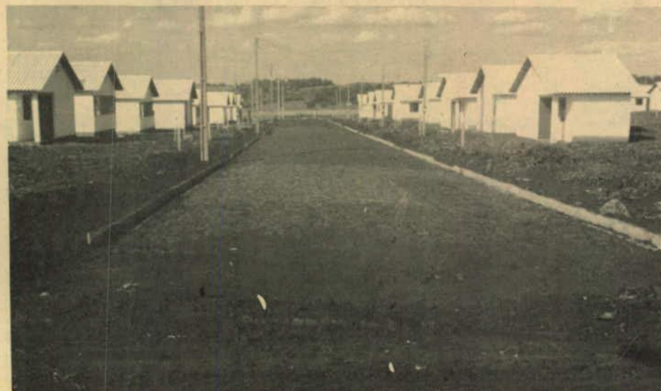
Pavimentação poliédrica pronta
