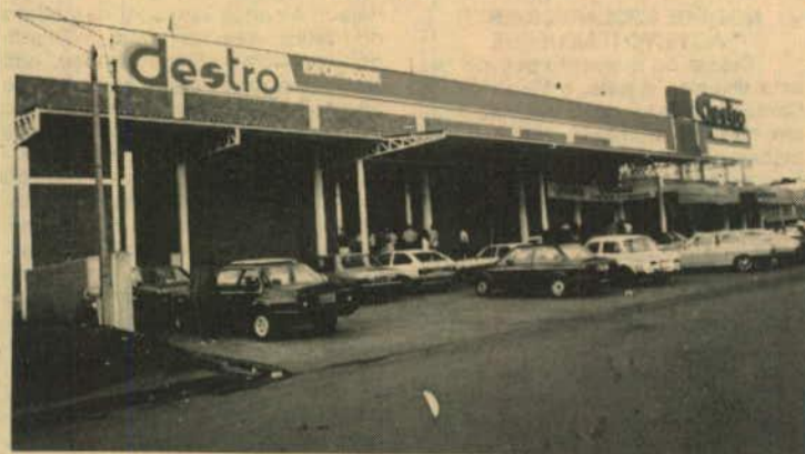
Vista parcial da fachada do Destro Macroatacado, situado na rua João Batista Debret, 500 - Vila Portes.
