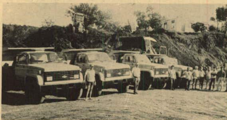
A aquisição recente de quatro caminhões basculantes vai agilizar "o canteiro de obras".
