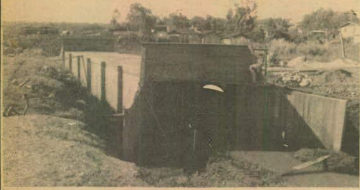
Ponte sobre o Rio Alegria na Rua Alagoas
