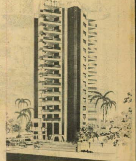
Edifício Solar das Laranjeiras - Avenida Paraná
