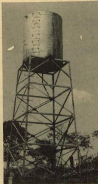
Microsistema de abastecimento de água no interior: melhoria da qualidade de vida para o homem do campo
