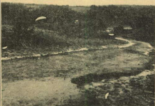
Estrada de acesso à foz do rio Iguaçu em ruínas
