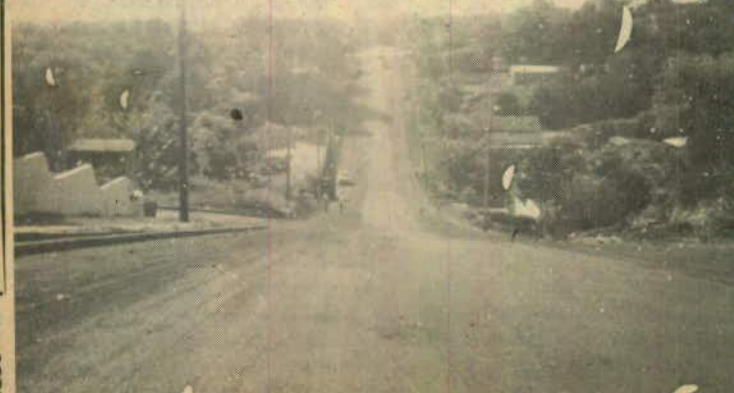
Asfalto concluído na Rua Belarmino de Mendonça
