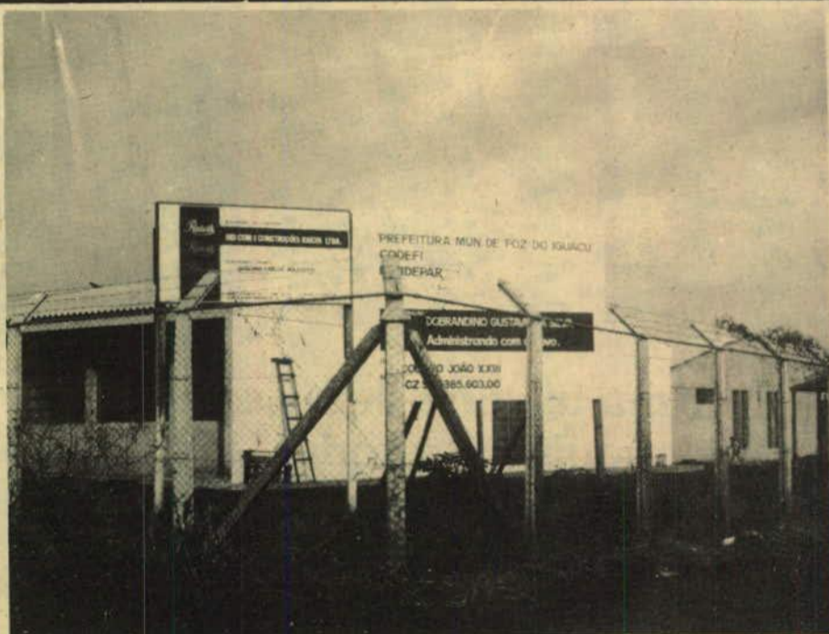
Colégio João XXIII, que está sendo construído no São Francisco
