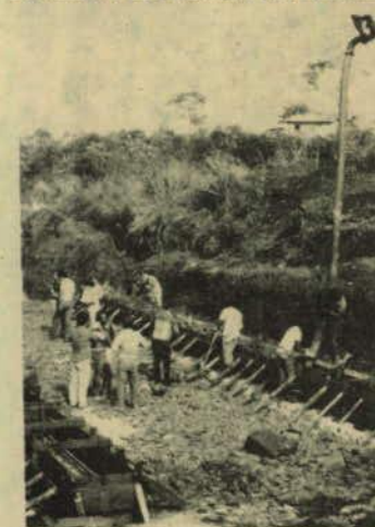
Obra da Codefi no rio Boici
