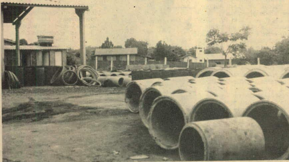
Fábrica de Artefatos de Concreto da Codefi
