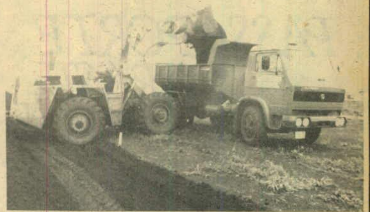
Prefeitura faz a terraplanagem da área de exposição
