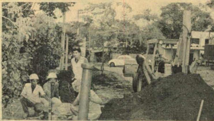
Obras de instalação da rede de esgoto
