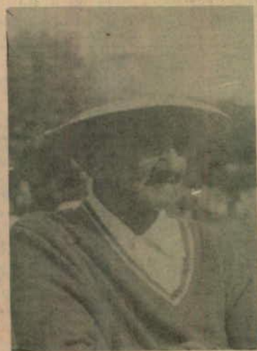
O velho de 75 anos assiste desolado à demolição da casa que construiu
