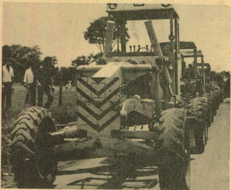
Máquinas começam a trabalhar na Av. República Argentina
