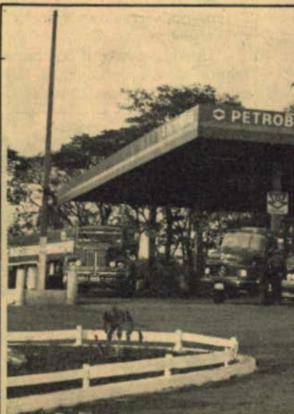
Caminhões da Transportadora Montoro em Santa Terezinha.
